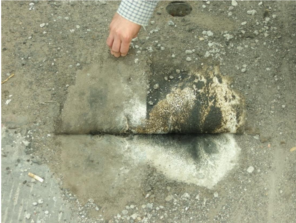
Fot. 6 Nie związana z podłożem izolacja płyty (papa samoprzylepna – zgrzewana)
